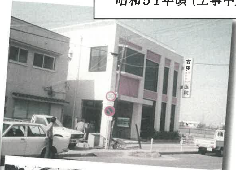
当院旧館（右） 昭和51年頃（工事中）
